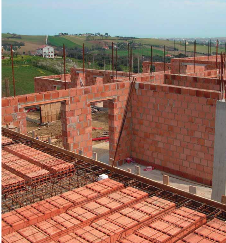
Residenze a Mondolfo (Pu): fase di esecuzione dell'orizzontamento tra il piano terra e il primo piano; vista aerea del cantiere.
