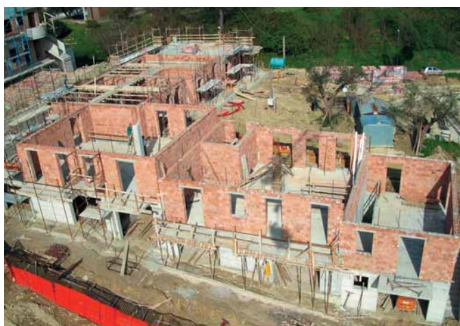
Residenze a Mondolfo (Pu): fase di esecuzione dell'orizzontamento tra il piano terra e il primo piano; vista aerea del cantiere.
