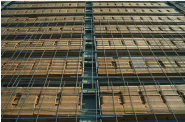
Fig. 3 - La prima fonte di salubrità di un ambiente costruito deriva dai materiali anche strutturali adottati: il solaio a lastre con blocchi di alleggerimento in laterizio è la premessa di base più valida.
